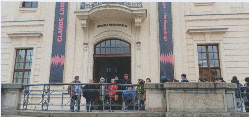
Ein Teil unserer Besuchergruppe vor dem Eingang des Altbaus (ab 1735 preuß. Kammergericht)
